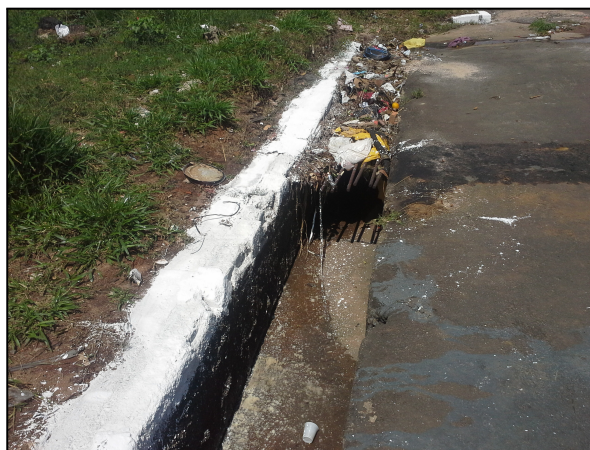
Fig. 15.2 Poluição por resíduos sólidos sobre a rede de drenagem
