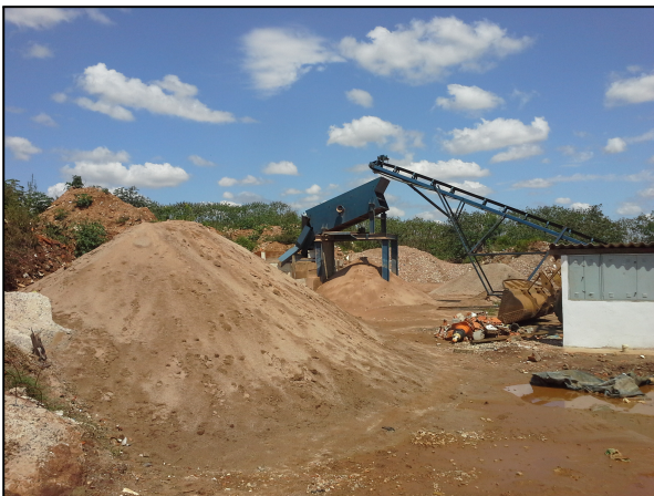
Fig. 13.1 Usina de processamento de resíduos da construção civil - particular
