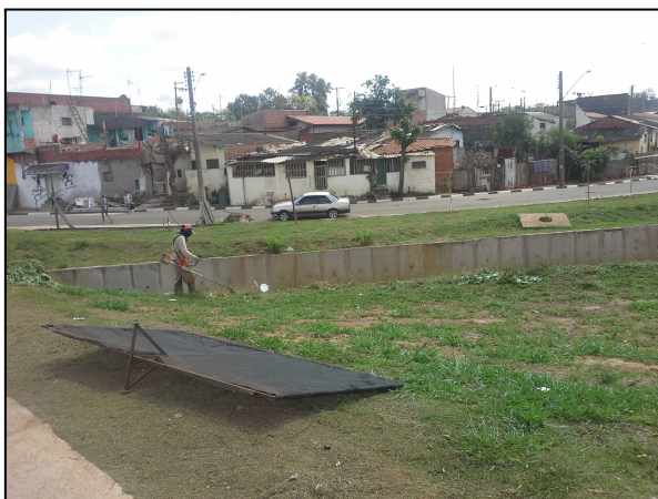
Fig. 14.1 Equipe contratada, efetuando serviços próximo à Av. Dona Renata
